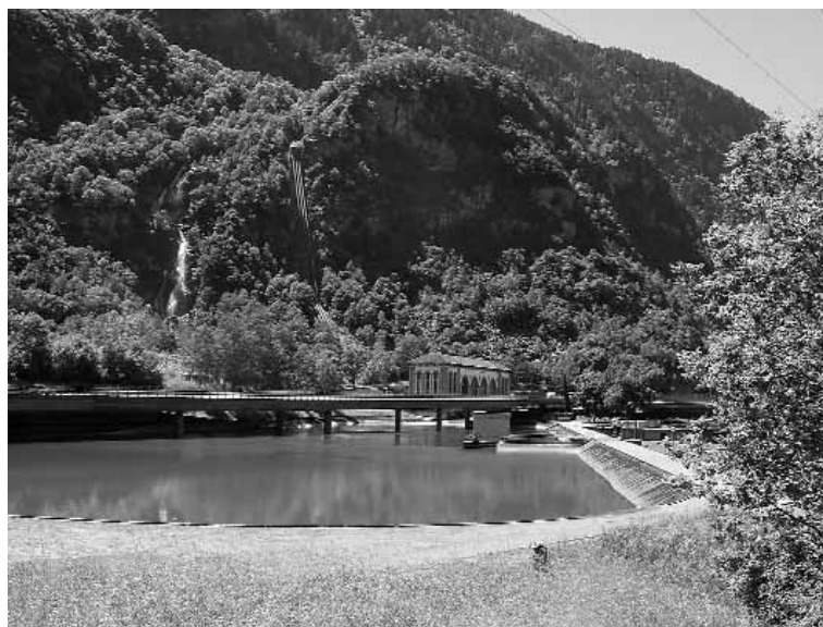
Fig. 1 – Il bacino di compenso di Nivo e la centrale del Piottino (da archivio AET)
