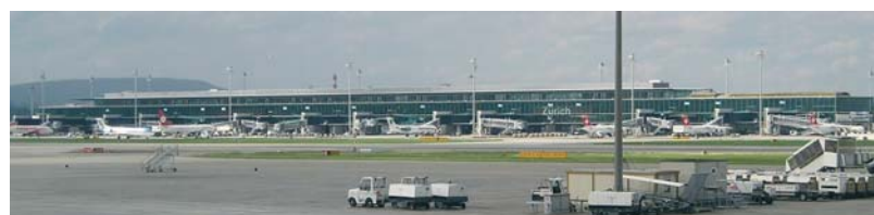
Figura 4: Dock Midfield dell'aeroporto di Zurigo. I pali di fondazione sono utilizzati per il geocooling ed il riscaldamento
