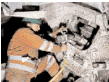
Un tecnico all'opera nel tunnel del Gottardo
