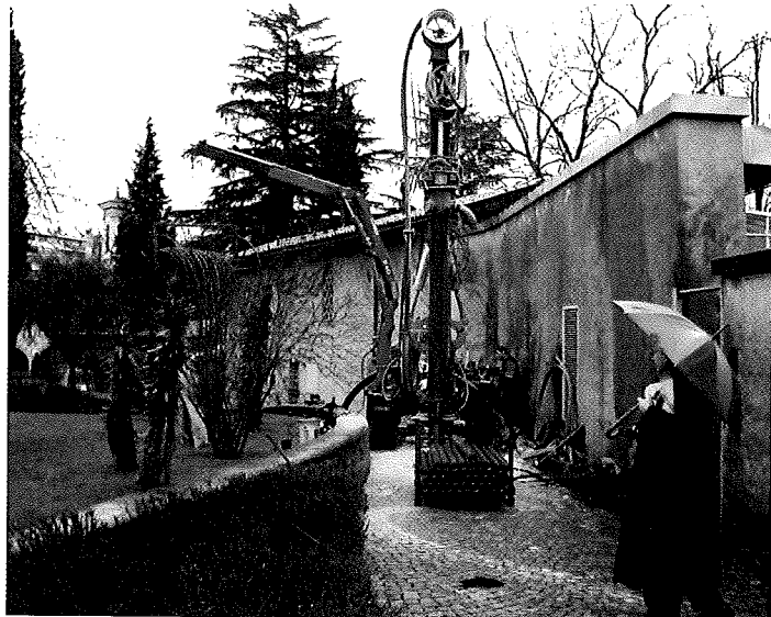
Perforazione per le sonde geotermiche (foto LEEE-SUPSI).
