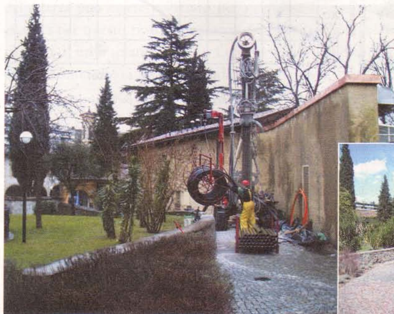
Figura 3: Perforatrice e tubi a U per le sonde geotermiche (foto LEEE-DACD-SUPSI)
