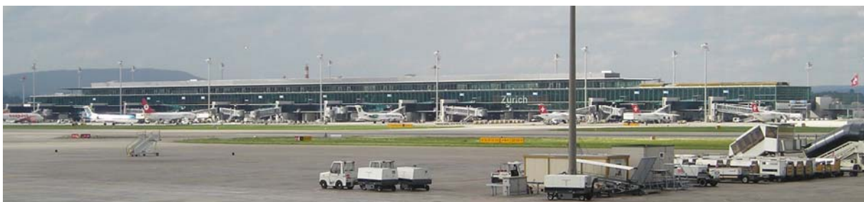
Figure 1.1 : Dock Midfield de l'aéroport de Zürich (photo D. Pahud)
